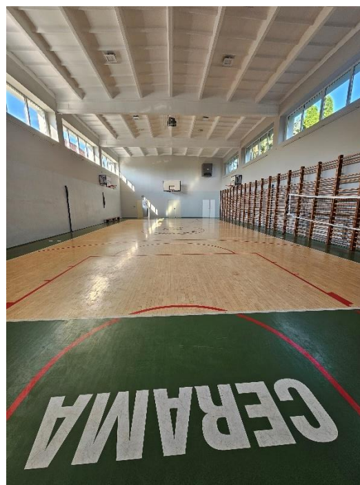
Zdjęcie 2. Z dotacji WRPO 2014+ dokonano termomodernizacji sali gimnastycznej w ZSP nr 1 w Krotoszynie. Wyremontowany obiekt oddano oficjalnie do użytku w Dniu Edukacji 2023.
