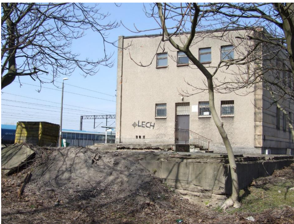
Fotografia 6. Stacja kolejowa w Krotoszynie, fot.2
