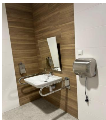
Zdj. 6 Sanitariat dla osób niepełnosprawnych
