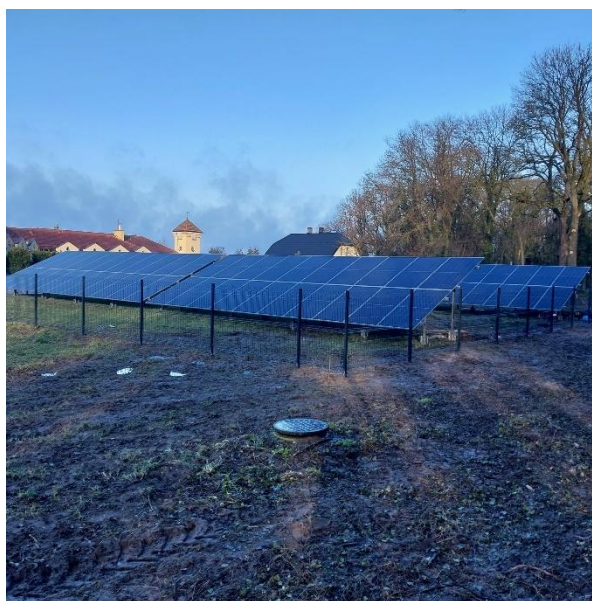
Zdjęcie 4. W listopadzie 2025 r. zakończono II etap montażu paneli fotowoltaicznych w DPS Baszków.
