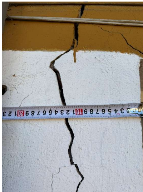
Fot.8 i 9 Północno-wschodni narożnik budynku przy wejściu głównym- widoczne spękania, górna szczelina o szerokości około 6mm
