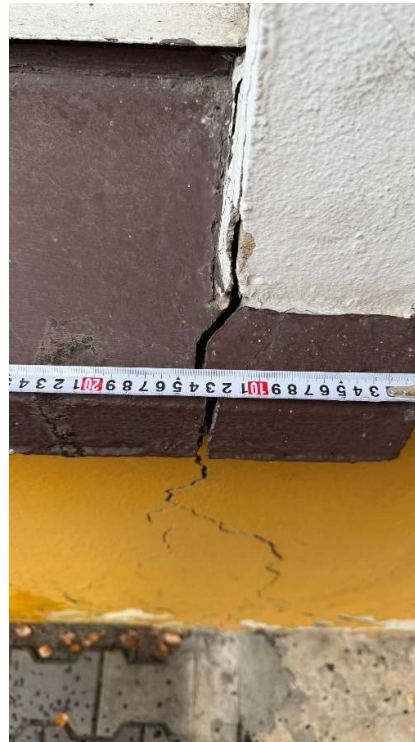
Fot.10 i 11 Elewacja od strony północnej przy wejściu głównym do budynku – pęknięcie ściany, szczelina o szerokości około 6mm
