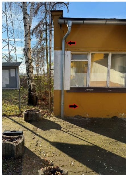
Fot.8 i 9 Północno-wschodni narożnik budynku przy wejściu głównym- widoczne spękania, górna szczelina o szerokości około 6mm
