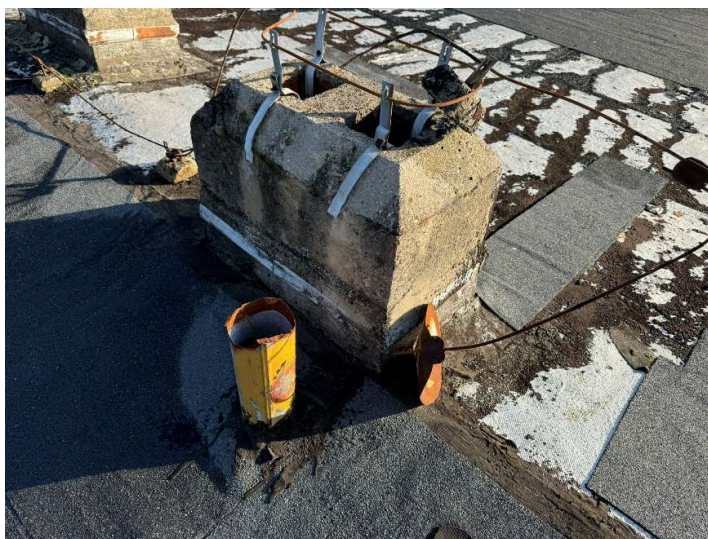
Fot. 20 i 21 Kominy wentylacyjne – murowane – widoczne spękania, łuszczący się tynk, kominiek stalowy
