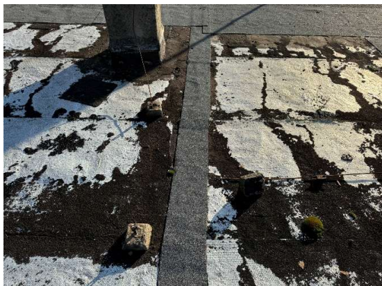
Fot.27 i 28 Pozrywane zwody poziome instalacji odgromowej. Poodrywane od podłoża uchwyty.
