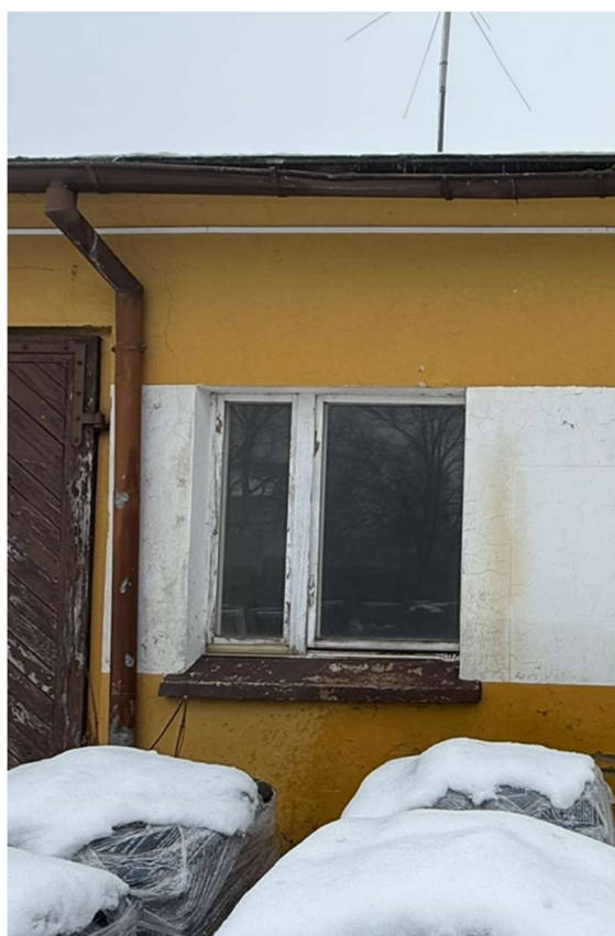
Fot.28 i 29 Stolarka drewniana w złym stanie wymagająca wymiany.
