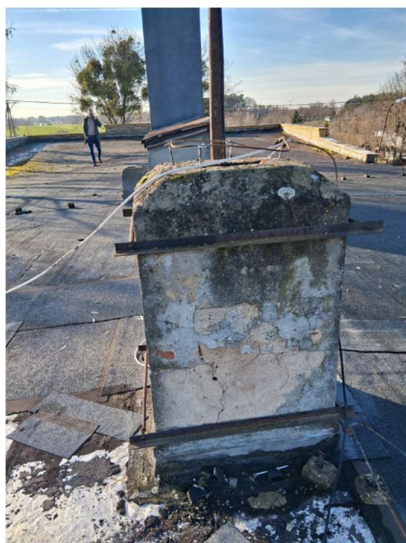
Fot. 20 i 21 Kominy wentylacyjne – murowane – widoczne spękania, łuszczący się tynk, kominiek stalowy
