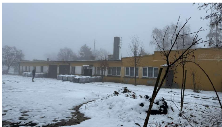
Fot.7 – Elewacja boczna, zachodnia
