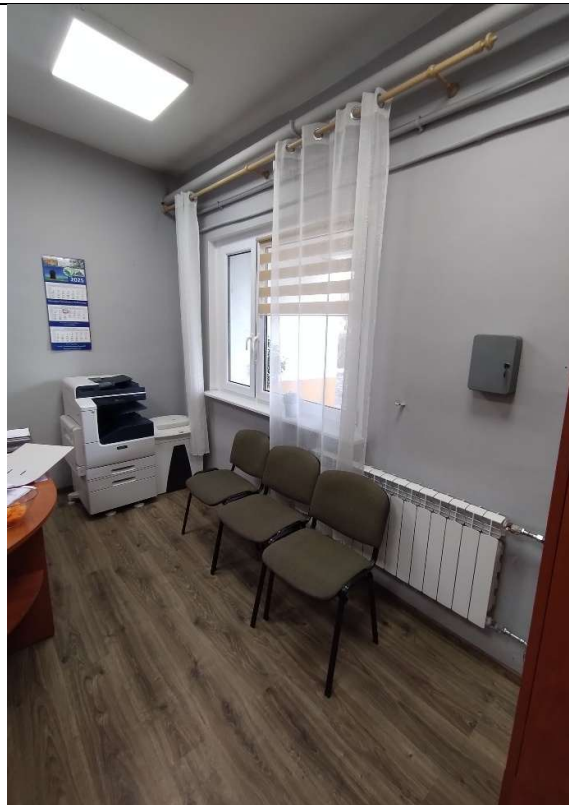
Fot. nr 12 – grzejnik aluminiowy z zaworem kulowym
