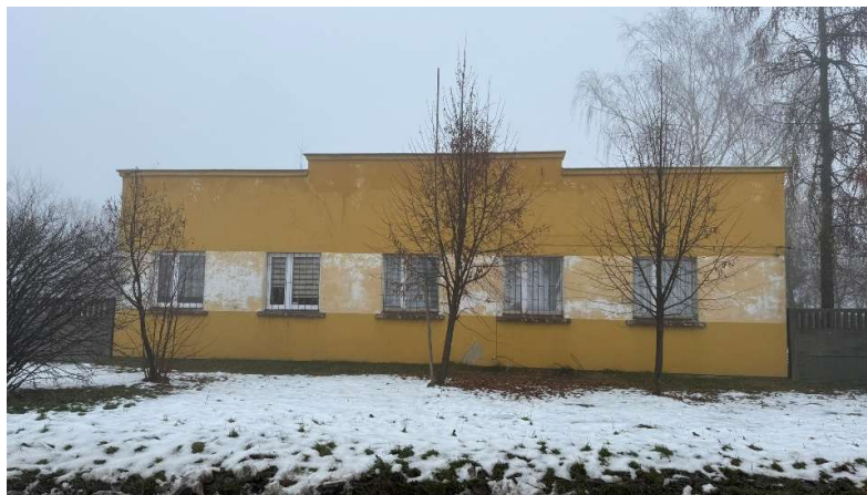
Fot.1 – Elewacja frontowa, widok od ulicy Transportowej
