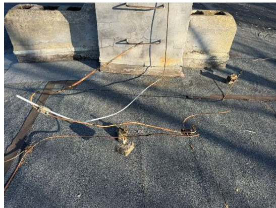
Fot.27 i 28 Pozrywane zwody poziome instalacji odgromowej. Poodrywane od podłoża uchwyty.
