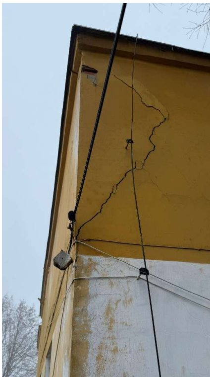
Fot.12 Elewacja od strony południowej- widoczne pęknięcie ściany w części attykowej
