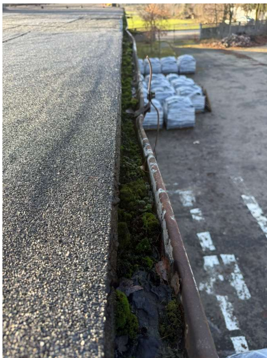
Fot.25 i 26 Pozalamywana rynna od strony zachodniej budynku. Wewnątrz zalegająca woda, błoto i mech. Widoczna rosnąca roślinność.
