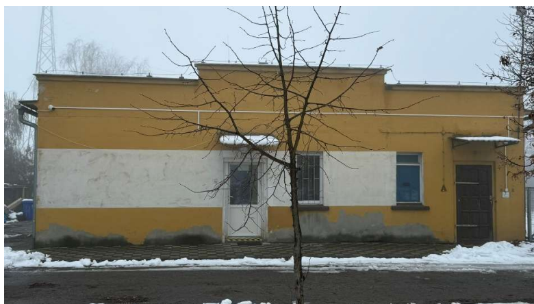
Fot.6 – Elewacja tylna, północna
