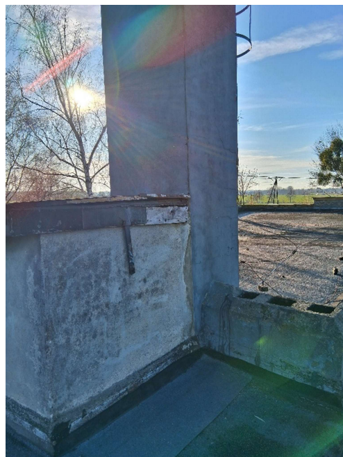
Fot. 18 i 19 Pokrycie dachu – skorodowana pokrywa
