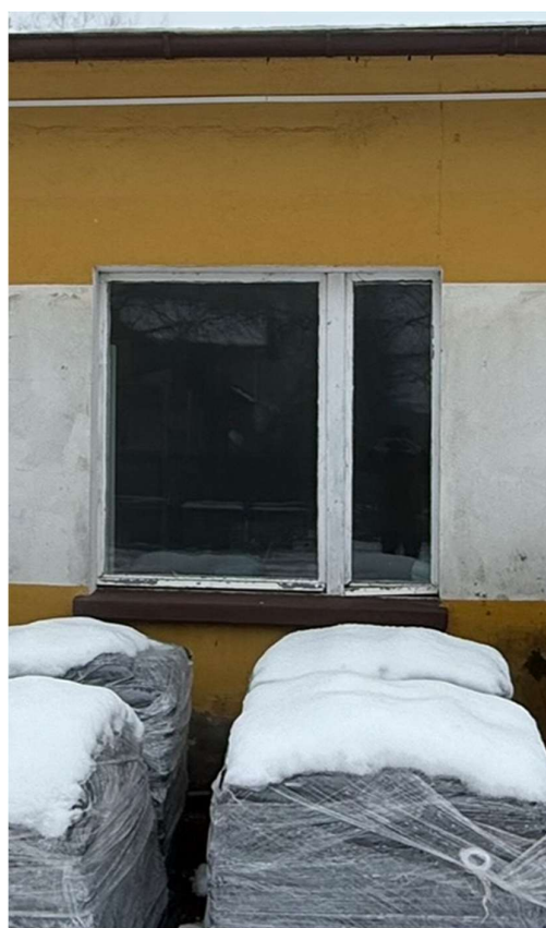
Fot.28 i 29 Stolarka drewniana w złym stanie wymagająca wymiany.
