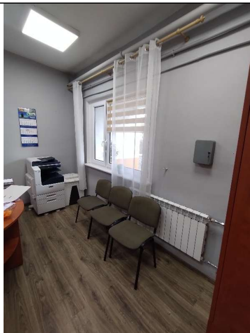
Fot. nr 9 – grzejnik aluminiowy członowy wyposażony w zawór kulowy odcinający
