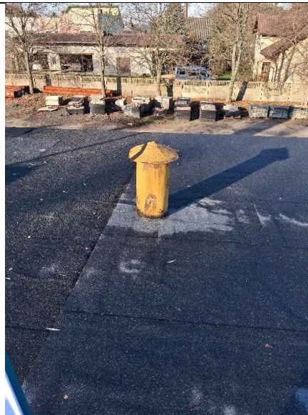
Fot. nr 14 – wywietrzak dachowy
