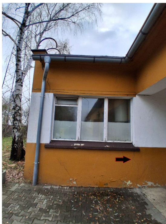
Fot.10 i 11 Elewacja od strony północnej przy wejściu głównym do budynku – pęknięcie ściany, szczelina o szerokości około 6mm
