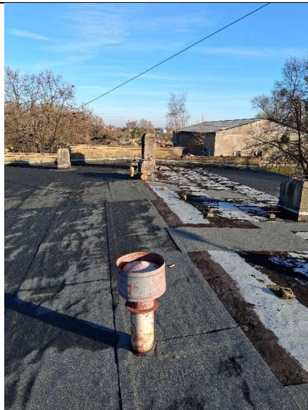
Fot. nr 13 – wywietrzak dachowy
