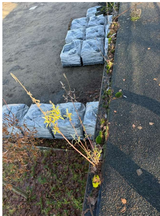
Fot.25 i 26 Pozalamywana rynna od strony zachodniej budynku. Wewnątrz zalegająca woda, błoto i mech. Widoczna rosnąca roślinność.
