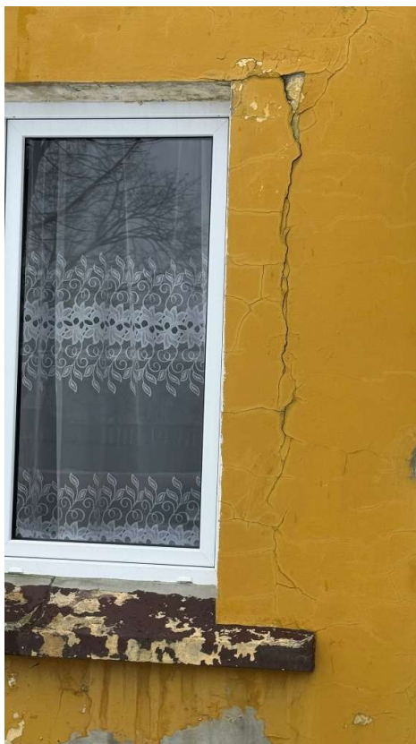
Fot.12 Elewacja od strony południowej- widoczne pęknięcie ściany w części attykowej
