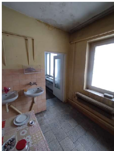
Fot.38 i 39 Pomieszczenia zaplecza. Widoczne ślady przecieków na suficie, Sanitariaty w złym stanie.
