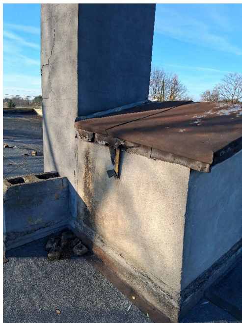
Fot. 18 i 19 Pokrycie dachu – skorodowana pokrywa
